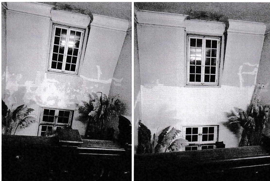
**Photos n°22 (à gauche) et photo 23 (à droite) prises en septembre 2023** : La photo 22 a été prise après la réparation des fissures sur le mur du demi palier qui mène au 4<sup>ème</sup>. La photo 23 a été prise suite au ratissage sur plus de la moitié du mur. Ce mur n'a pas encore été peint. La couleur blanche visible est dû à l'enduit de lissage utilisée en dernière étape du ratissage.
