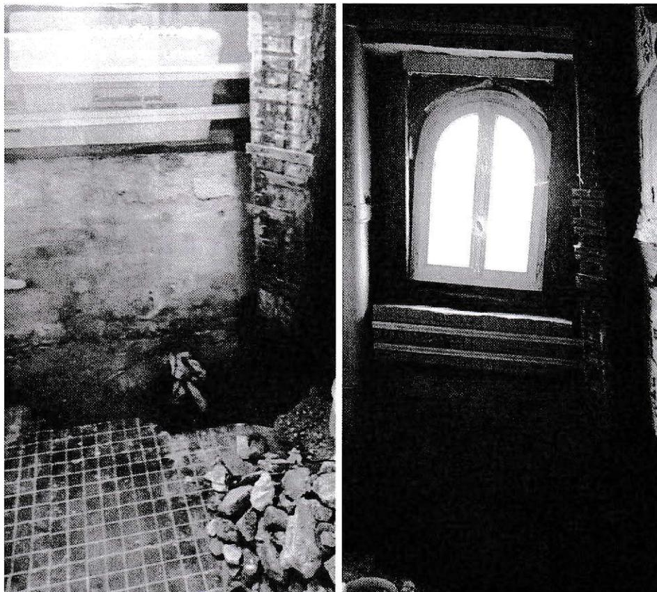
**Photos n°17 – prises fin avril 2025 :** Ces clichés montrent la poutre structurelle située dans l'angle de la salle de bains de l'appartement du 4e étage. On y constate une dégradation importante sur sa partie inférieure. La poutre ne repose d'ailleurs plus sur celle du plancher, cette dernière s'étant désagrégée au point de se réduire en poussière.
