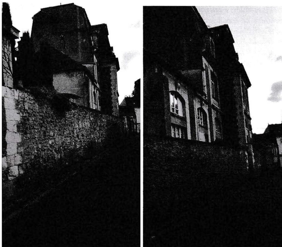
**Photos n°12 – Mur de la cour B côté rue (prises le 03/05/2025)** : Ces photos, prises après l'intervention de désherbage réalisée par les agents municipaux, montrent l'état actuel du mur longeant la cour B du château, côté rue. On y constate également que certaines plantations, appartenant à un copropriétaire, débordent régulièrement sur ce mur en direction de la voie publique. Cette situation perdure depuis plusieurs années (voir photo n°16 à l'appui).
