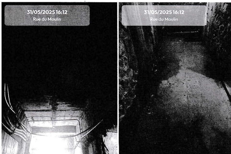
**Photos n°20 (à gauche) et n°21 (à droite)** : La photo n°20 présente l'état du plafond de la cave commune située sous la cour B. On y distingue des traverses métalliques fortement dégradées, témoignant d'un état avancé de corrosion. En cas de fortes pluies, l'eau s'infiltrant à travers le sol de la cour B provoque régulièrement des inondations dans cette cave. La photo n°21 montre le sol de cette même cave, où l'on peut observer des débris provenant de l'effritement du plafond.
